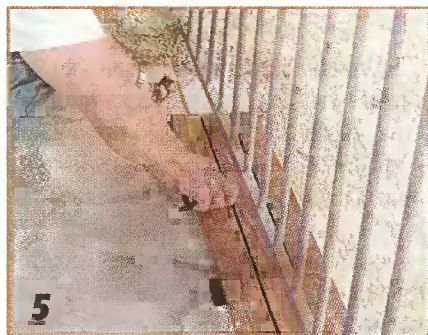
В конце ряда измеряют оставшееся расстояние до стенки. При этом учитывают 5 мм для компенсации влияния температурных колебаний.
