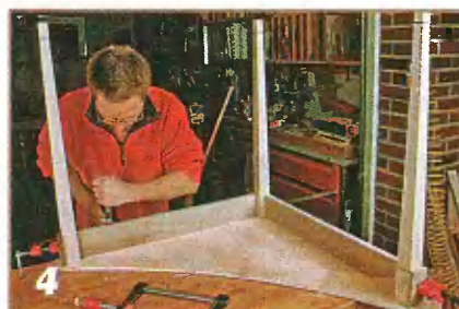
Выпилите и приклейте ножки и боковые царги. Для установки их под прямым углом используйте в качестве направляющей шаблон.
