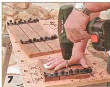
Торцевую пластиковую опору снимают, вывинчивая саморезы.
