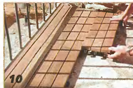
Параллельная установка блоков наиболее проста. Её выполняют очень легко и быстро, так как боковые соединения совпадают.
