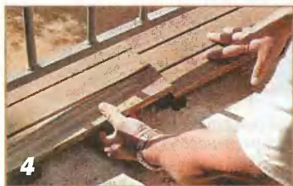
Вставляя один блок в другой, создают первый ряд решётчатого настила.
