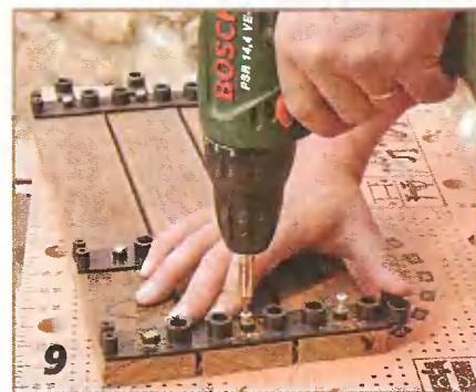
Пластиковую опору устанавливают в торец отрезанного блока.
