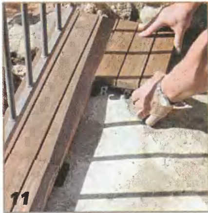
11 Для установки блоков в шахматном порядке используют половинные блоки решётчатого настила. С него начинают второй ряд, чтобы получить перекрытия стыков.
