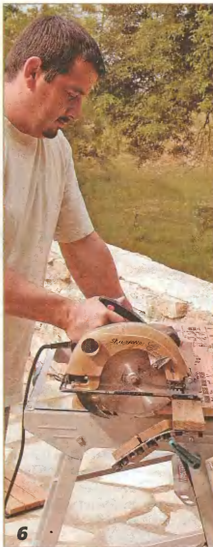
Излишнюю часть блока отрезают дисковой пилой с диском с твёрдосплавными накладками на зубья, предназначенным для пиления твёрдой древесины.
