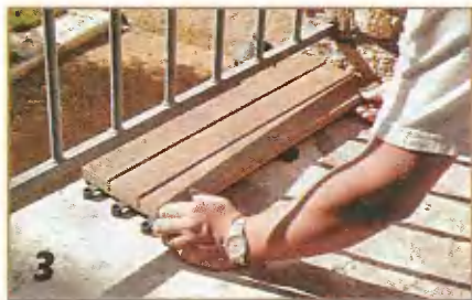
Обычно установку настила начинают с угла прямого участка застилаемой поверхности.
